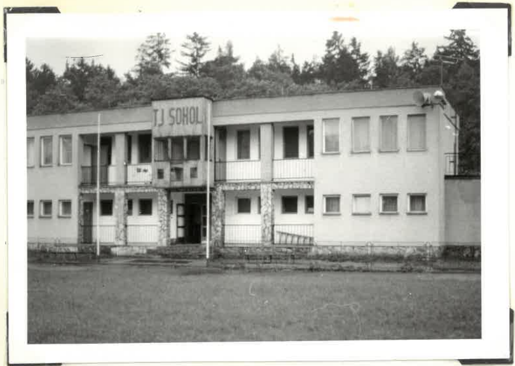
Semboková na nové ubytování
